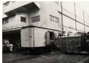
貨庫での入庫風景。2階と3階の間にある帯状の突起が一部外部防熱鉢巻き工法
