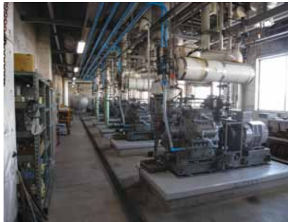
機械室は、元々は加工等を行う予定で設計された部屋だったため、大きな窓が設置されている。
