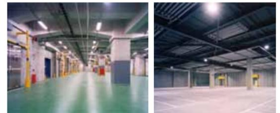
荷捌室床のコンクリート配合強度を30N/㎡とし、樹脂塗床よりも耐摩耗性を安定させた。
