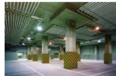
高さ1.7mのパレラックを使用するため庫内の天井が高く設計されている。
