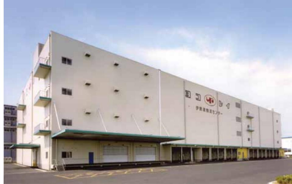
伊勢原物流センター (2005 (平成17)年) 温度帯が違う各棟 (冷蔵棟、荷捌棟、常温棟) は、温度収縮による建物の破損を防止するため、エキスパンションにより分離されている。
