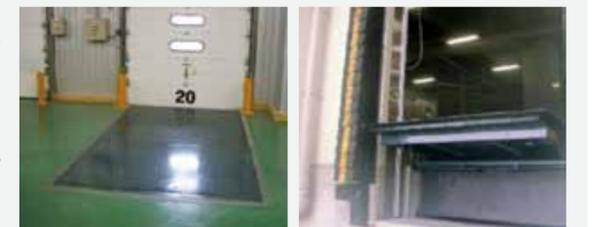
バースの高さが可変可能なドックレベラー トラックの荷台の高さに合わせてバースの接車口を上下させることが可能。フォークリフトが直接トラック内まで入ることができる。
