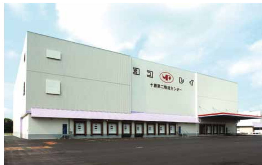
十勝第二物流センター (2008 (平成20年))
