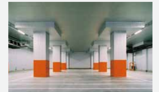
十勝第三物流センター倉庫内フラットスラブ構造の柱。
