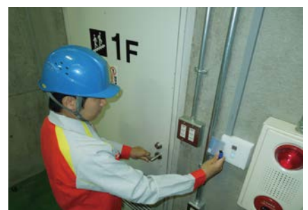
ICカード入退館管理システム IC Card Facility Access Management System
