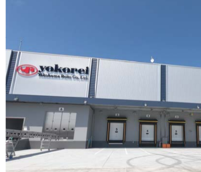
ヨコレイで産地工場と位置づける、凍結・生産設備を持つ冷蔵・冷凍倉庫。倉庫容量8500㎡、凍結能力180㎡で、サバやイワシ、サンマ、カツオなどを扱う。最新設備の導入で省力化を実現、屋上に同社最大規模の太陽光発電システムを設置する。
