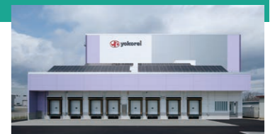
「十勝フードバレー物流センター」外観
